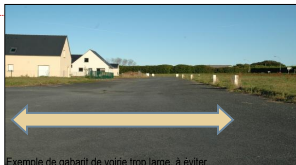
Exemple de gabarit de voirie trop large, à éviter
