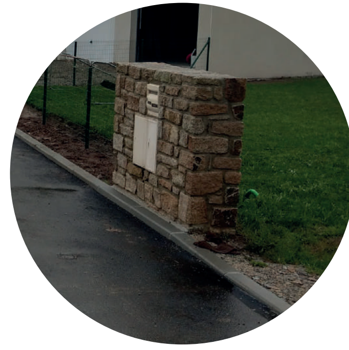
Muret en moellons
