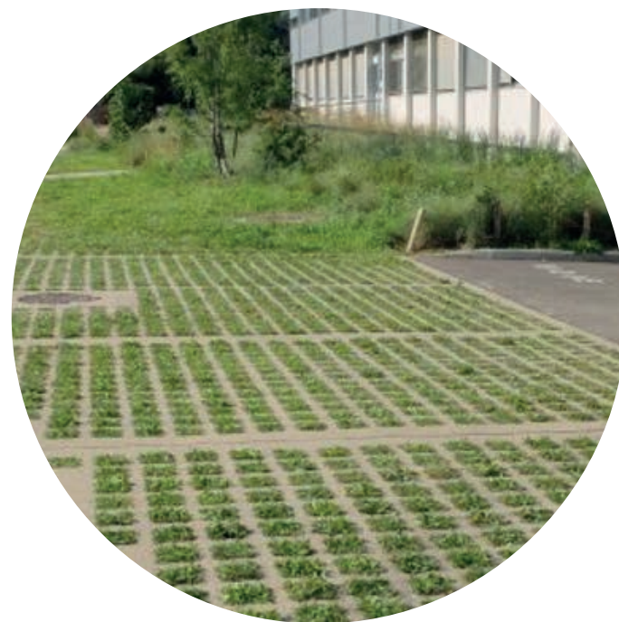
Stationnements végétalisés de type Via verde
