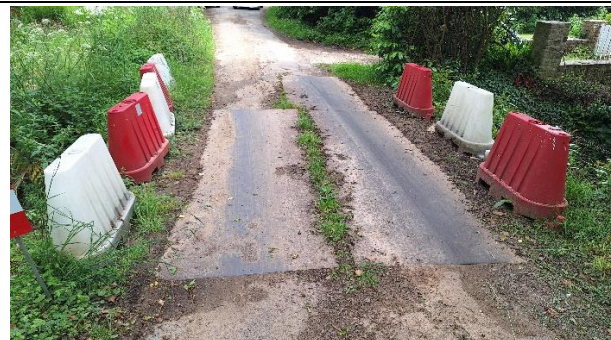
Photo 2 : Vue générale du Pont de Coat Boulouarn
