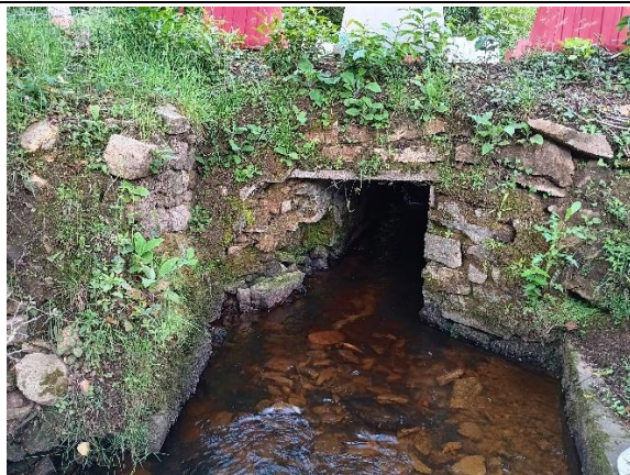
Photo 1 : Elévation aval du Pont de Coat Boulouarn
