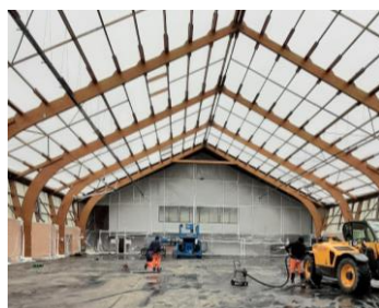
Structure mise à nue avant renforcement et principe de renforcement des arcs en bois lamellé-collé
