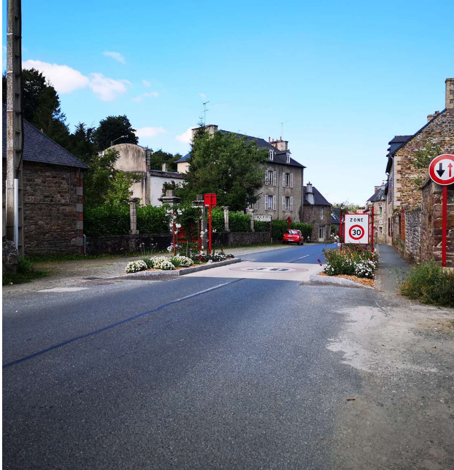
SEUIL DE LA ZONE 30 AVEC ÉCLUSE AXÉE
