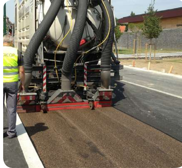
Enrobé Goasq + traitement de surface
