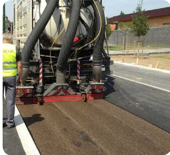
Enrobé Goasq + traitement de surface
