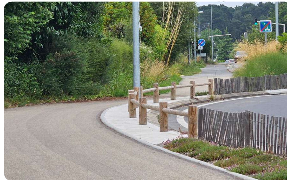
Barrière bois rondin utilisée en zone rurale par intermittence
