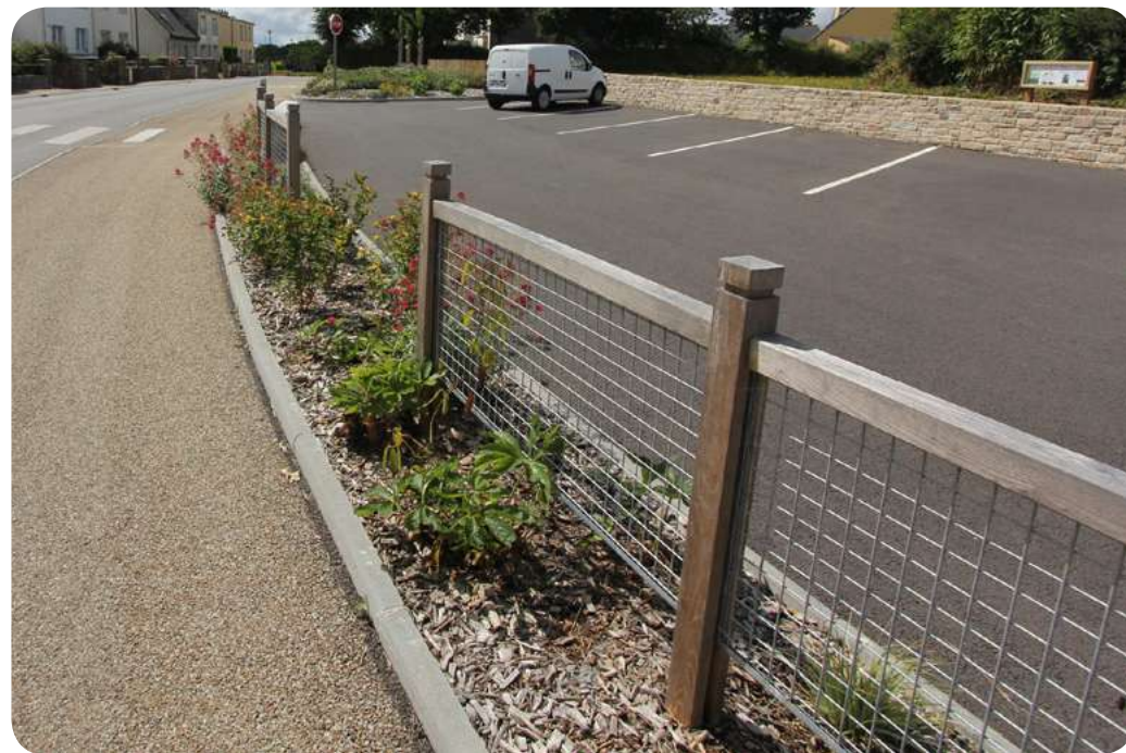
Modèle de barrière bois et metal a reprendre en zone urbaine par intermittence
