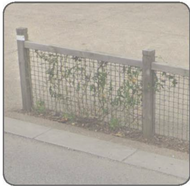
Des barrières plantées pour sécuriser
