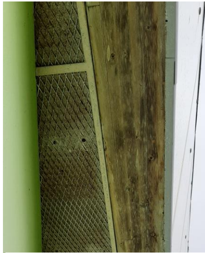
Bardage métallique dans trémie d'escalier
