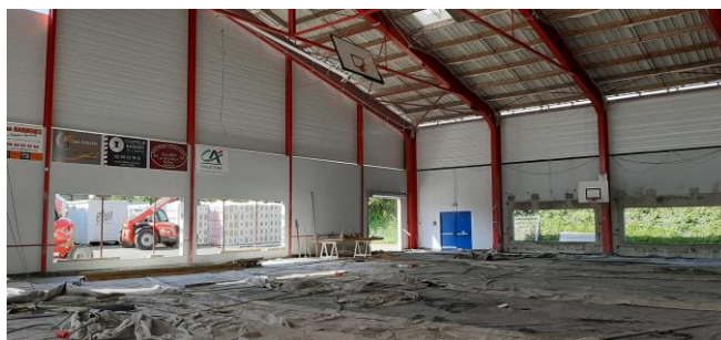
Volume annexe décloisonné suite au curage du bâtiment
