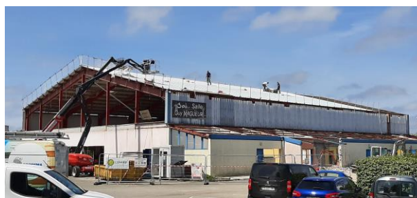
Pose de lanterneaux de désenfumage
