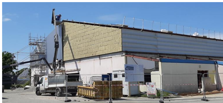
Juin 2022 – pose de l'isolation et du bac acier en façade Sud
